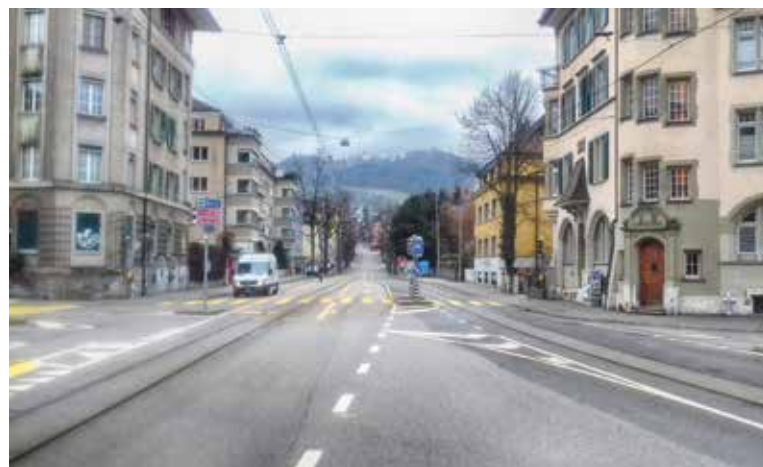
Von hier bis rauf zur Seftigenstrasse wird die Monbijoustrasse saniert.
