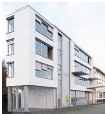
So soll das Haus Bahnstrasse 44 nach der Sanierung aussehen.
