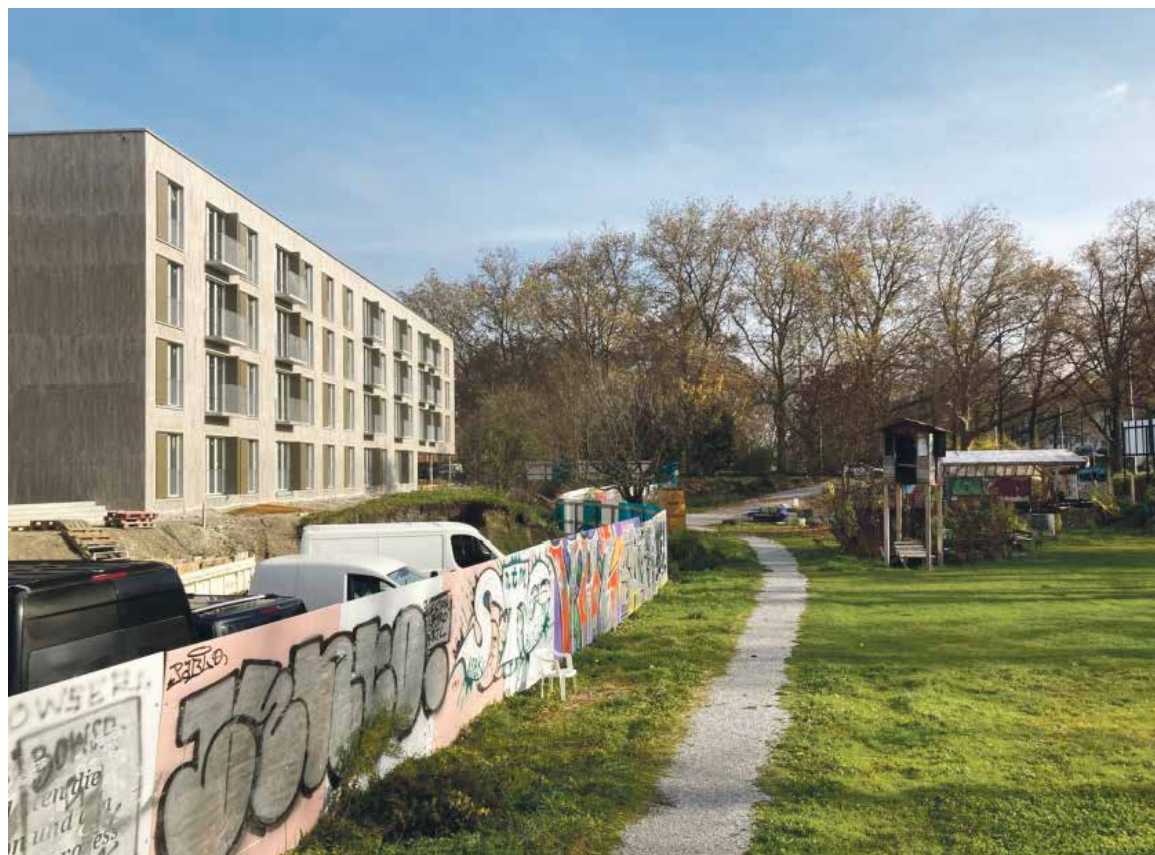
Der Bauzaun kommt Anfang Sommer weg; der öffentliche Bereich wird grösser (Bild: Stadtgrün Bern)
