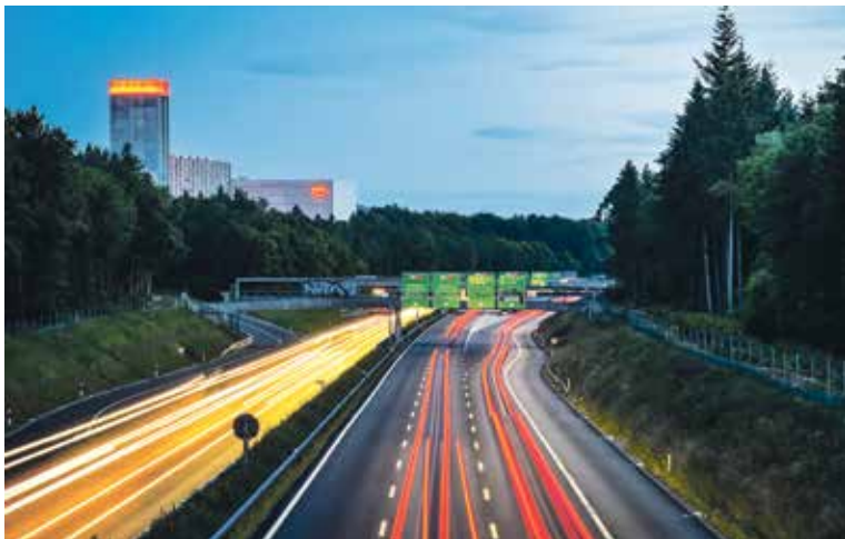
Die Energiezentrale EWB liefert bald auch Fernwärme ins Holligenquartier (Bild: ewb).
