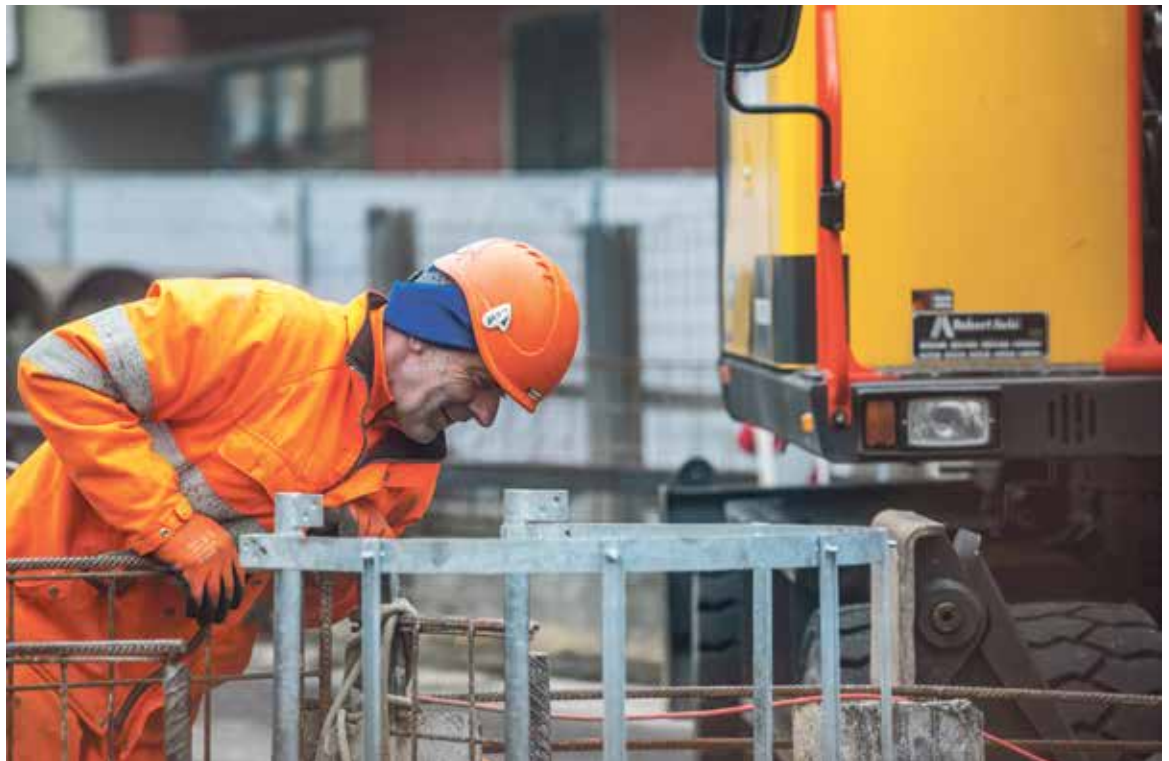
Während im Dezember noch mehrheitlich unter dem Boden gearbeitet wurde, verlagert sich das Geschehen nun an die Oberfläche (Bild: Alexander Egger)
