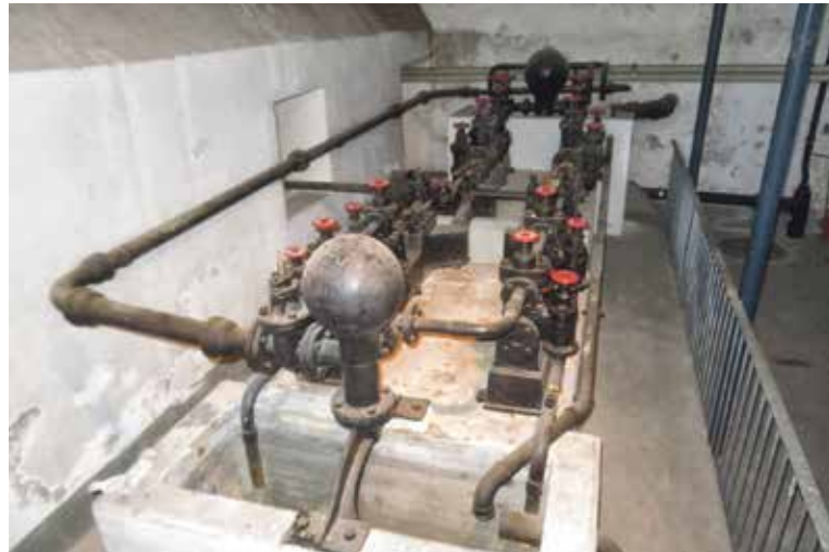
Noch vorhandene Anlage der Maschinenfabrik Giroud-Olma Olten mit Baujahr 1881.
