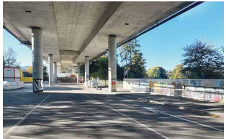
Der Raum unter dem Viadukt wird neugestaltet. (Bild: acct)
