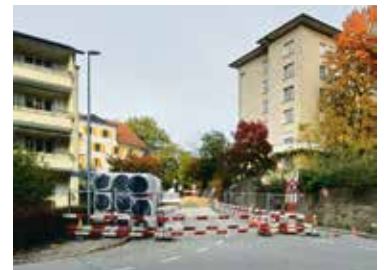
Auch die Friedbühlstrasse bekommt eine Fernwärmeleitung (Bild acct).
