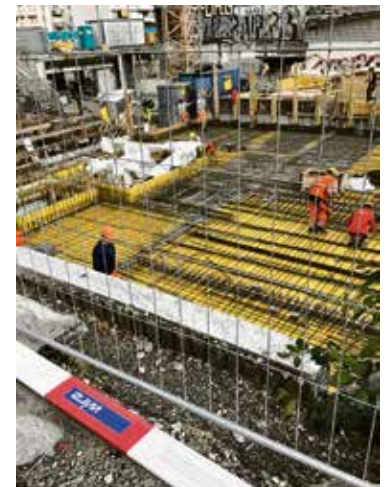
Meinen Süd (Blick gegen Osten): Hier sind die Betonarbeiten bereits in vollem Gange. (Halter AG)
