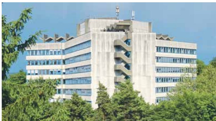
Das ehemalige Zieglerspital dient als Empfangs- und Verfahrenszentrum (EVZ) Bern.
